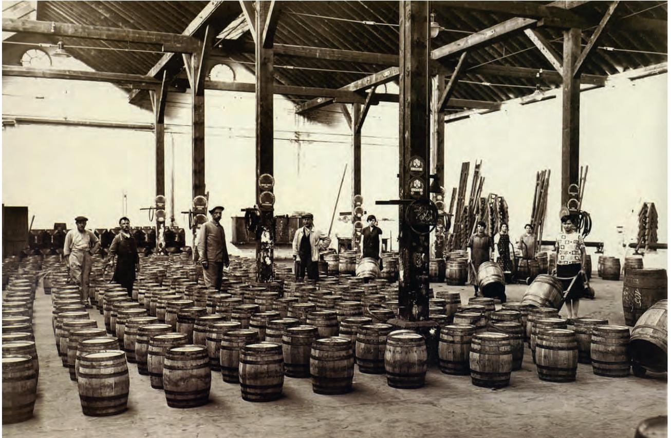
Figure 8. Avant l'utilisation de barils métalliques standardisés, le conditionnement à des fins d'expédition de l'indigo se faisait avec des tonneaux en bois cerclés d'acier. Le tarage, le pesage du produit et surtout la fermeture et l'étanchéisation des tonneaux étaient des opérations salissantes, longues et délicates, utilisant une nombreuse main d'oeuvre souvent très jeune. Archives Ciba.
