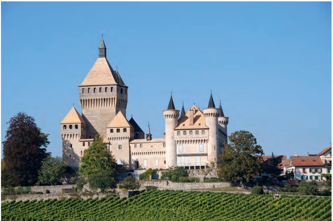
Figure 5. Le château de Vufflens, magnifique exemple d'architecture militaire en briques d'inspiration lombarde, dresse son imposante silhouette dans l'arrière-pays de Morges. La couleur claire des briques donne à penser que leur fabrication s'est faite à partir d'argiles relativement riches en calcaire, probablement d'origine locale. Photographie Th. Mumenthaler.
