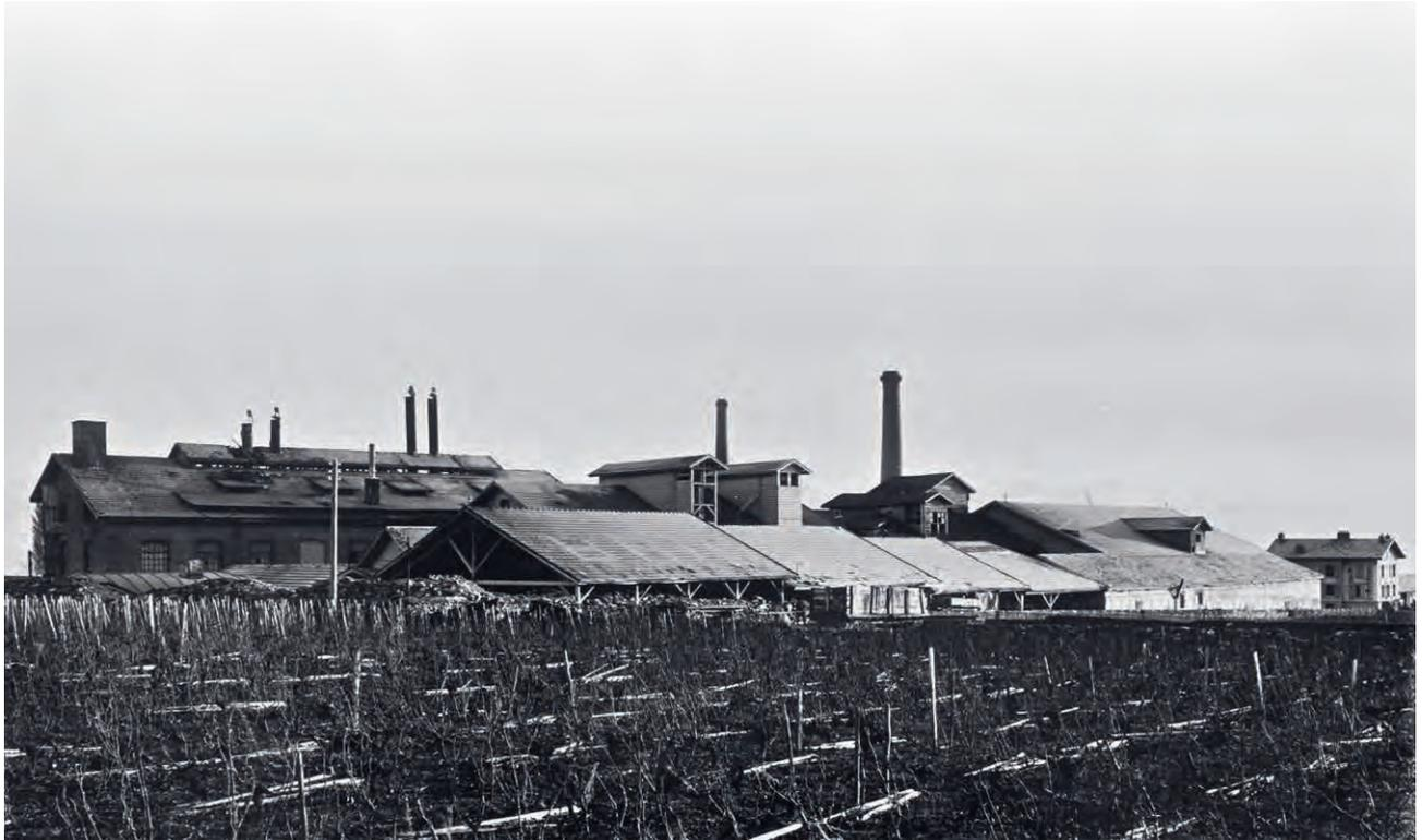
Figure 13. Dès 1774, le charbon extrait des mines de La Paudèze fut utilisé entre autres à la fabrication de verre, de tuiles et de ciment. A la fin du XIX<sup>e</sup> siècle, une grande usine située près du lac produisait la « paudézite » un ciment fabriqué avec le calcaire marneux extrait des mines de charbon. De nos jours, il ne subsiste que la grande maison visible tout à droite de l'image. Photo G. de Jong. Original sur plaque de verre. Collection Photo Elysée.
