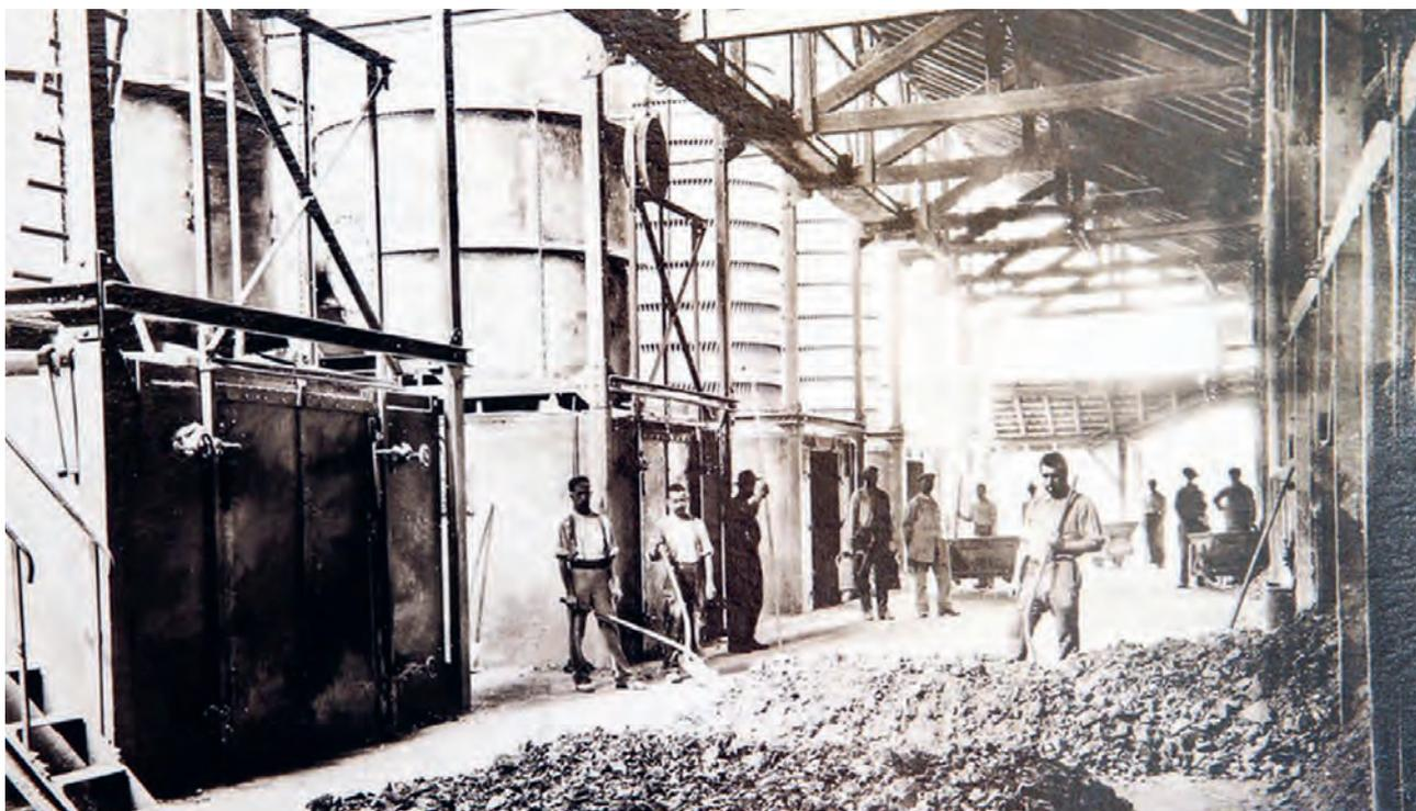
Figure 11. Tas de blocs de calcaire, issus des silos à gauche, et prêts à être enfournés par des ouvriers appelés « chauffourniers » dans des fours à chaux à l'usine de chaux et ciment de Baulmes au début du XX<sup>e</sup> siècle. Collection Musée du vieux Baulmes.
