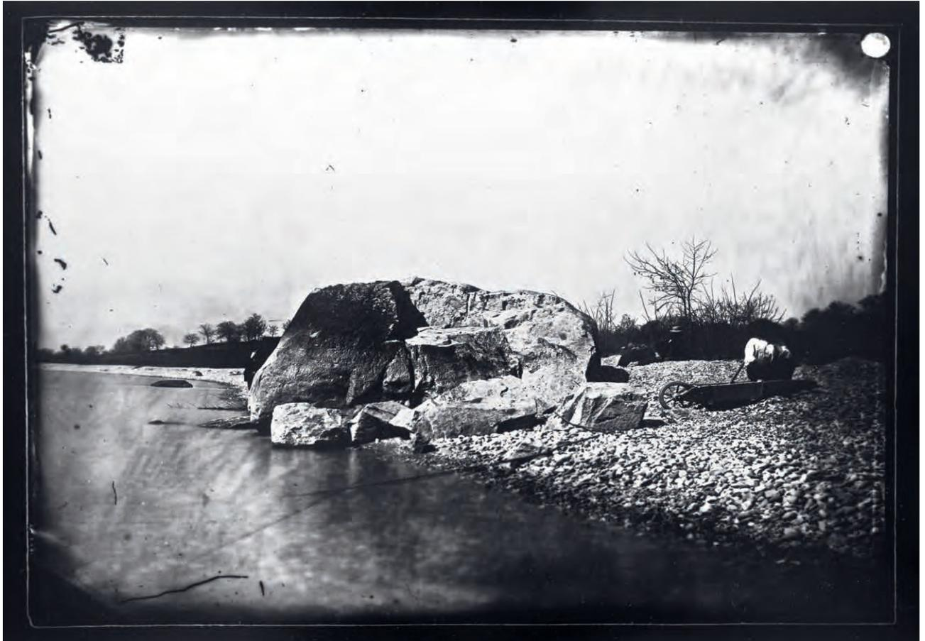
Figure 3. Débitage d'un bloc erratique au bord du Léman (Saint-Prex) à la fin du XIX<sup>e</sup> siècle. Les blocs erratiques amenés par le glacier du Rhône lors de la dernière période glaciaire furent intensément exploités et utilisés comme matériau de construction. Photographie anonyme. Original sur plaque de verre. Collection Photo Elysée.
