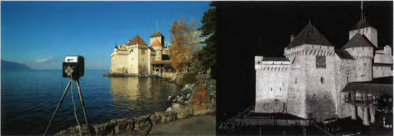
Figure 6.—Numérisation des façades du château de Chillon avec un scanner à longue portée et le nuage 3D enregistré.
