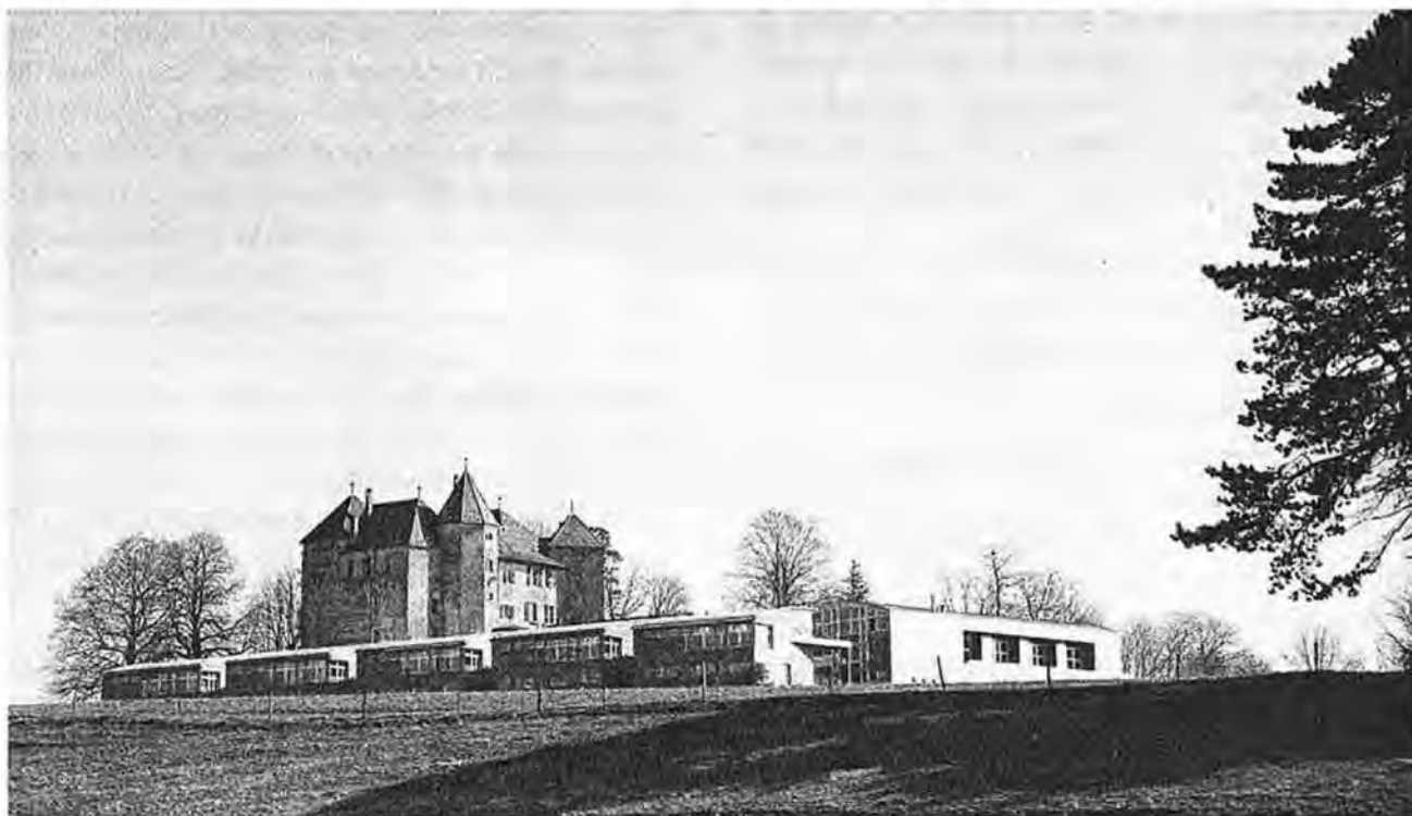
Vue d'ensemble depuis le vallon du Talent. Photographie: E. Stierli, architecte.
